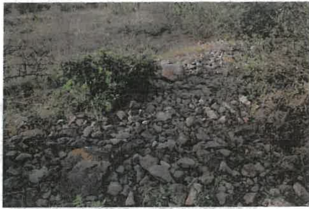
Exemple de clapas non-structuré existant sur le site
