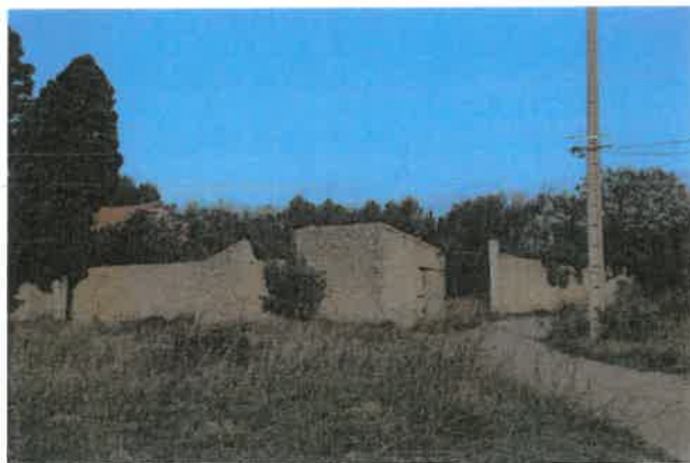
Enclos et bâtiments attenants
